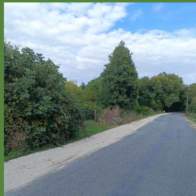
Aménagement pour les piétons route de Villiers-en-Plaine
