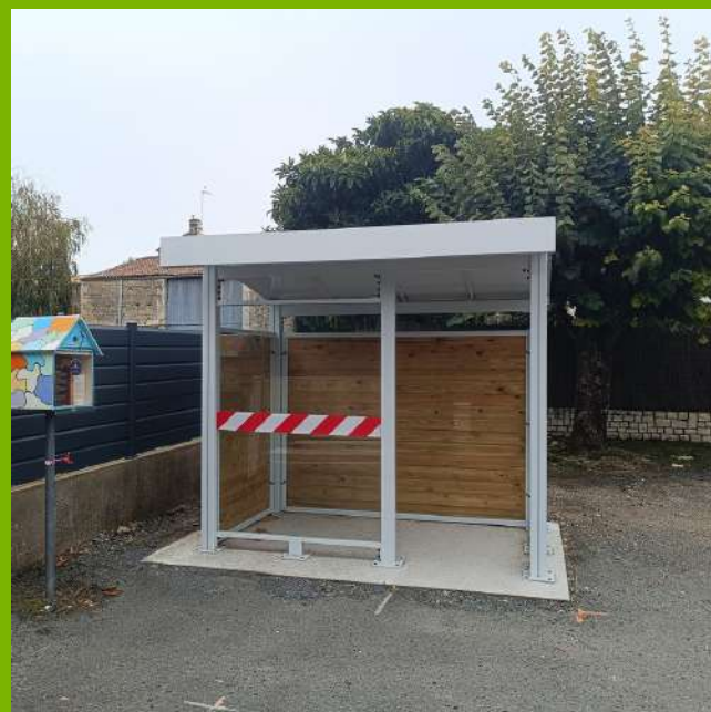
Création d'un abribus sur la placette
