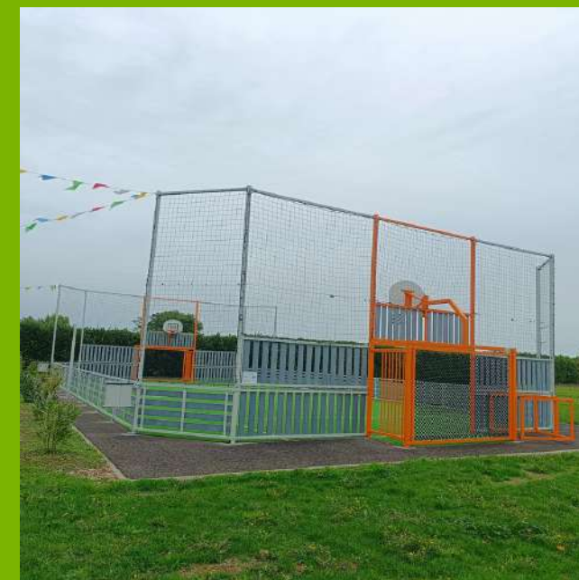
Construction d'un city stade sur l'ancien stade de Lesson
